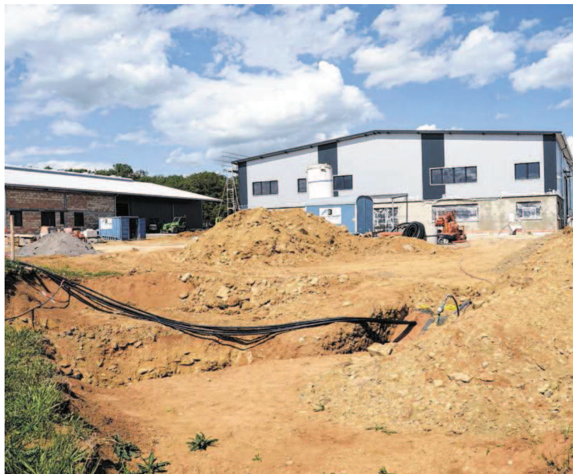
Intensiv gebaut wird derzeit im Industriepark A 81 bei Tauberbischofsheim. Unser Bild zeigt links das Vorhaben der Firma Knorsch, rechts den Neubau der Firma Feilmeier. BILD: SEYBOLD
